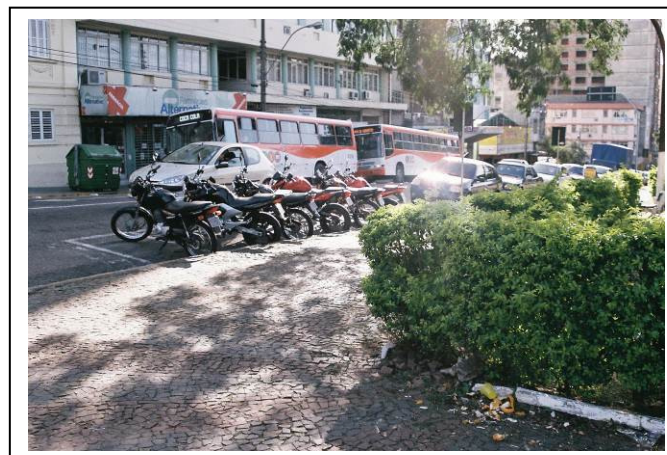
Figura 4. Calçadas em má condição e depósito de lixo na praça central da Av. Rio Branco
