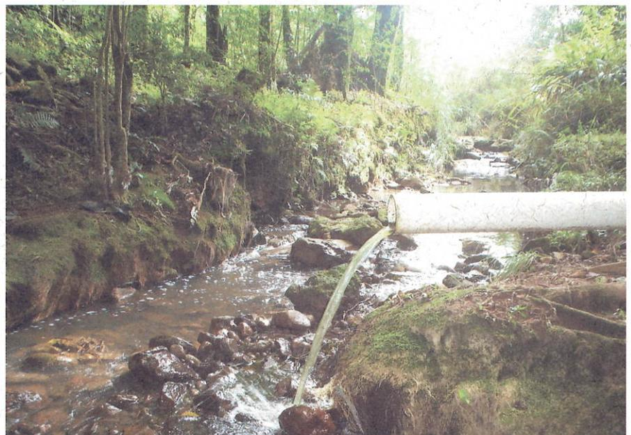
Figura 3: Ponto de Lançamento do efluente tratado no corpo receptor
