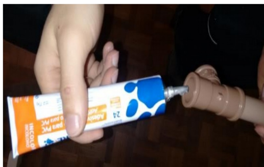
Figura 4: a cola deve ser passada na parte interna das conexões e, após, na ponta do cano que entrará nela.
