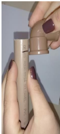
Figura 3: Marcação das conexões. Para facilitar a colocação das conexões nos canos, determine a profundidade da conexão e marcar esta profundidade na ponta de todos os canos. Marcação para todas as conexões.
