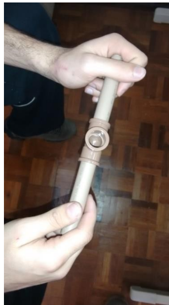
Figura 5 e 6: certifique-se de que o cano entrou aproximadamente até a marcação.
