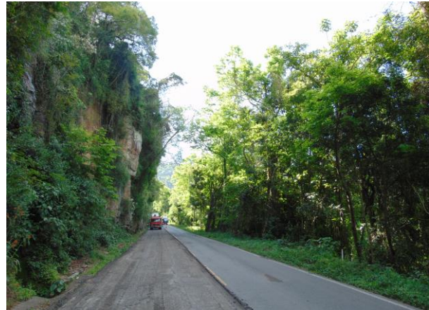
Figura 12. Talude no km 189 + 500
