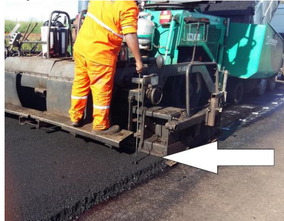
Imagem 5. Verificação da espessura de lançamento do CBUQ
