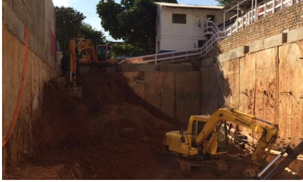
Figura 7. Escavação em andamento
