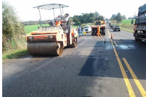
Imagem 3. Compactação com rolo liso
