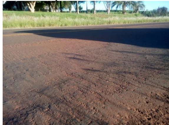
Figura 3 - Corrugação no trecho RS 305 entre Tuparendi e Tucunduva/RS
