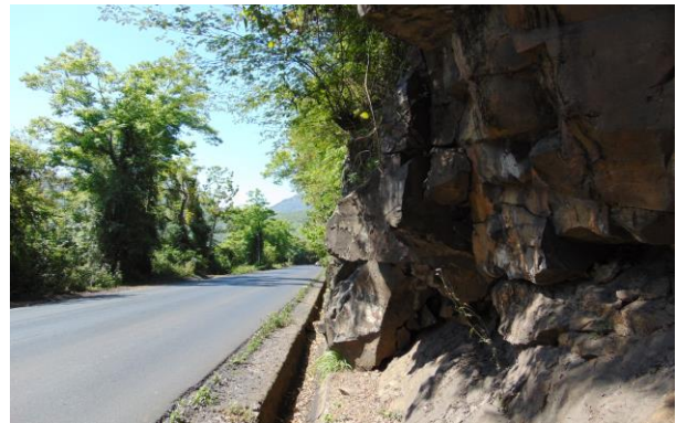
Figura 4. Talude no km 194 + 800
