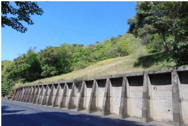
Figura 2. Contenção no km 196 + 300
