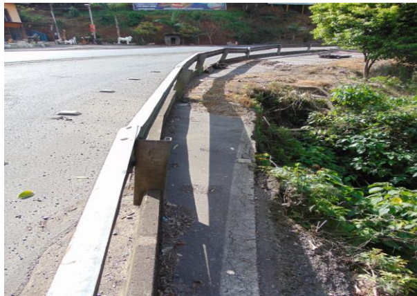
Figura 10. Talude no km 188 + 900
