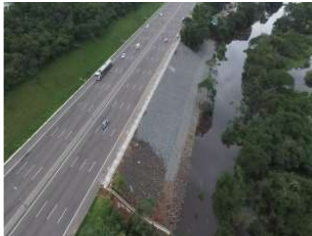
Figura 12. Obra emergencial da recuperação talude concluída
