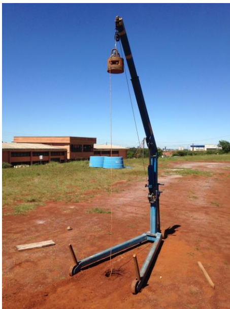
Figura 3 - Bloco içado pronto para queda livre.
