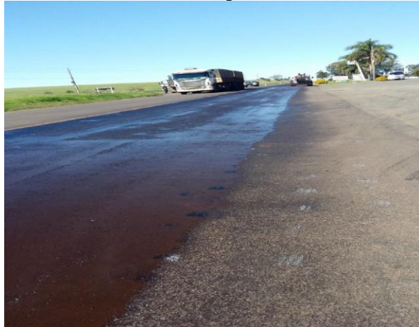
Imagem 4. Pintura de ligação para execução da capa
