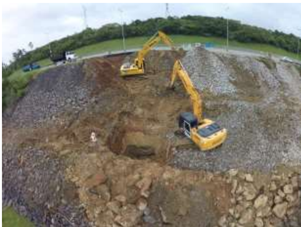
Figura 11. Escavação do nicho para realização da chave granular
