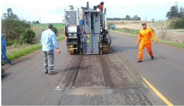
Imagem 1. Fresagem do pavimento
