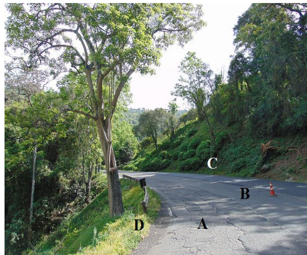
Figura 8. Talude no km 188 + 400
