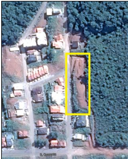
Figura 2. Localização do Talude.
