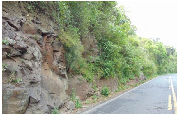
Figura 14. Talude no km 192 + 800
