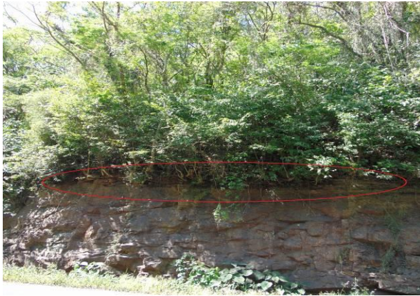
Figura 6. Talude no km 194 + 400
