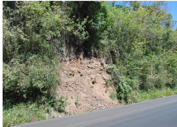
Figura 16. Talude no km 196
