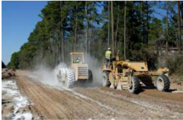
Figura 2. Emprego da cal na estabilização de solo para fins rodoviários (fonte: MINASCAL, 2017)
