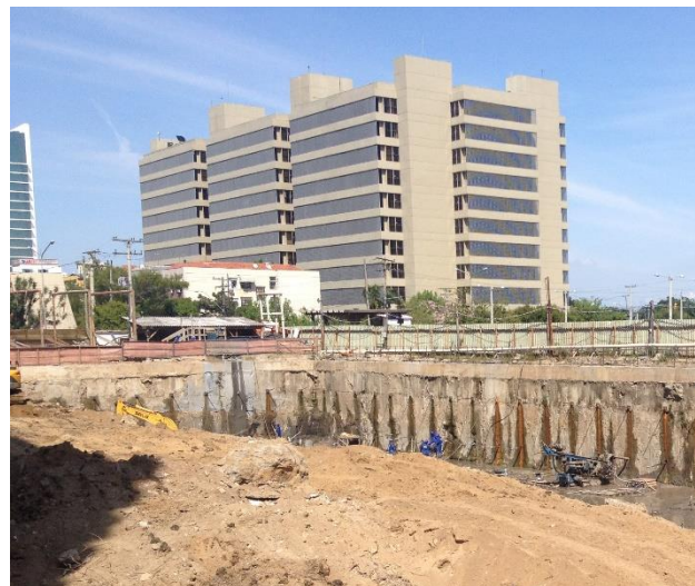
Figura 2. Início da escavação
