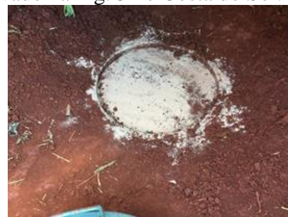
Figura 3: Ruptura por puncionamento
