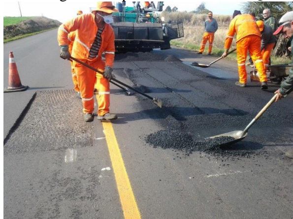
Imagem 2. Espalhamento do CBUQ
