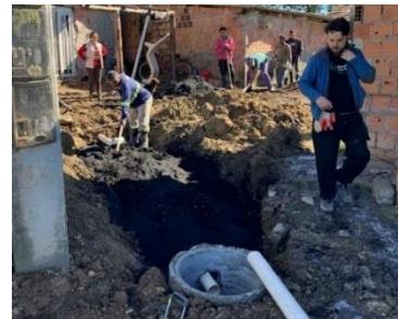
Figura 03 – Instalação da tubulação no entrono das residências.
