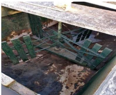
Figura 2. Floculador mecanizado de eixo vertical
