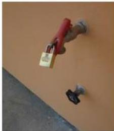
Figura 1: modelo de torneira para evitar o uso como potável, na Creche Hassis (PMF, 2019).
