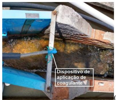
Figura 1. Mistura rápida calha Parshall
