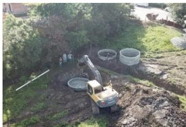
Figura 02 – Instalação conjunto Fossa séptica e Filtro anaeróbico.
